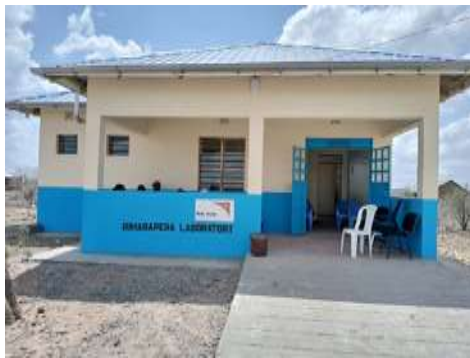
リマラペラ臨床検査室
